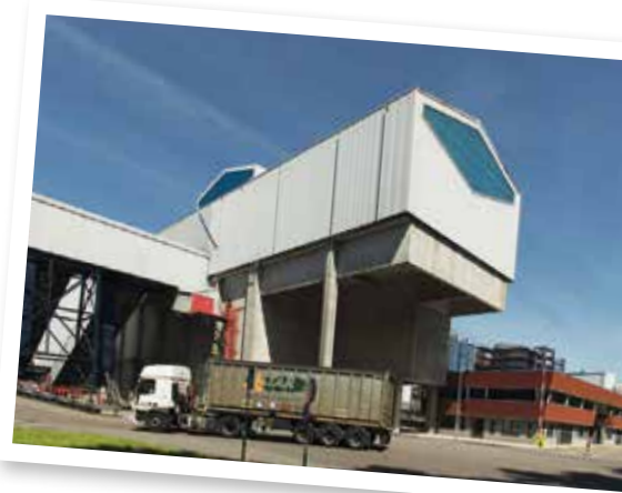
▲ De vergistingsinstallatie van ARN. (foto: William Moore)
