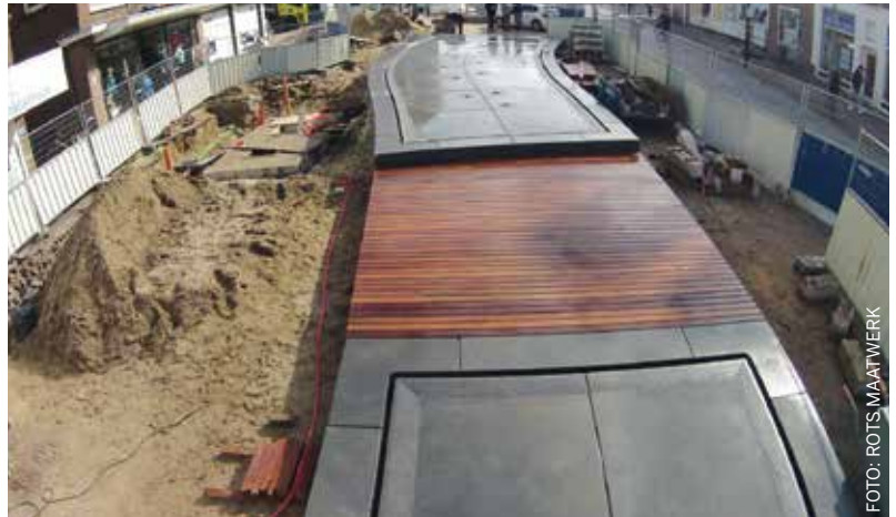
▲ Het waterwerk in aanbouw.
