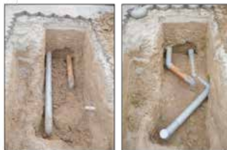
◀ Figuur 1. In de linker grafiek zijn de temperatuurmetingen in de riolering van 25 tot 28 mei 2013 opgenomen. Voorafgaand aan de reparatie van de huisaansluiting op 27 mei zijn dagelijks meerdere temperatuurpieken (gele en rode strepen) waarneembaar in het hemelwaterriool, die duiden op een foutaansluiting. Na de reparatie op 27 mei ontbreken deze pieken en is het probleem verholpen. De linker foto toont de huisaansluitingen vóór reparatie; de rechter foto na reparatie.
