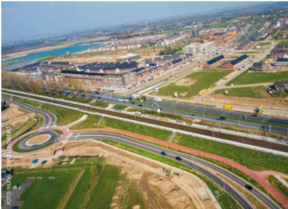
▲ Overzicht van het warmteleveringsgebied Nijmegen-Waalsprong
