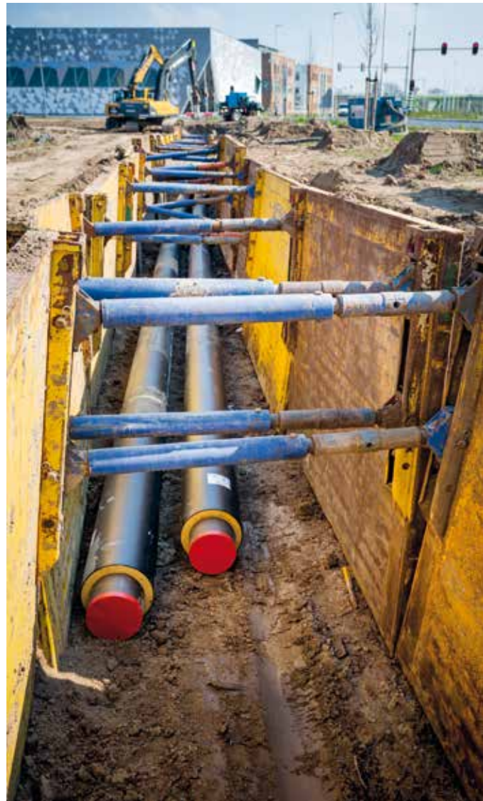
▲ Aanleg van een stadswarmtenet.
