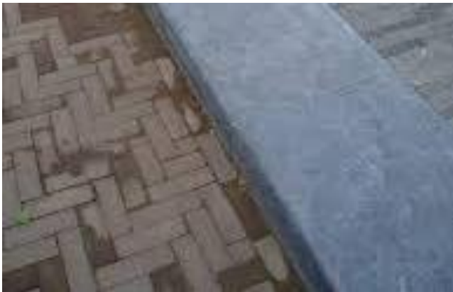
Hardsteen, na aanleg
